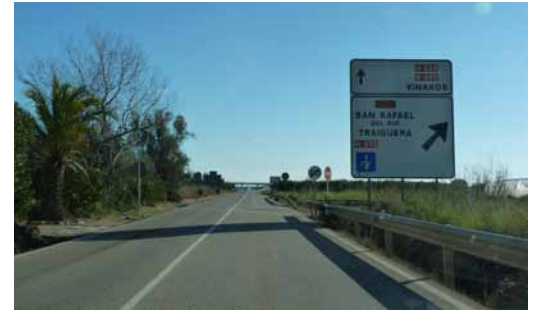
La carretera N-238 necessita millores urgents
