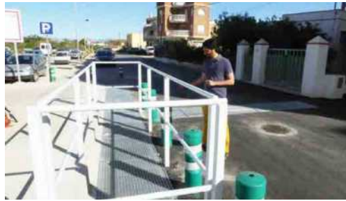
Conclouen les obres dels pluvials del Camí Fondo
