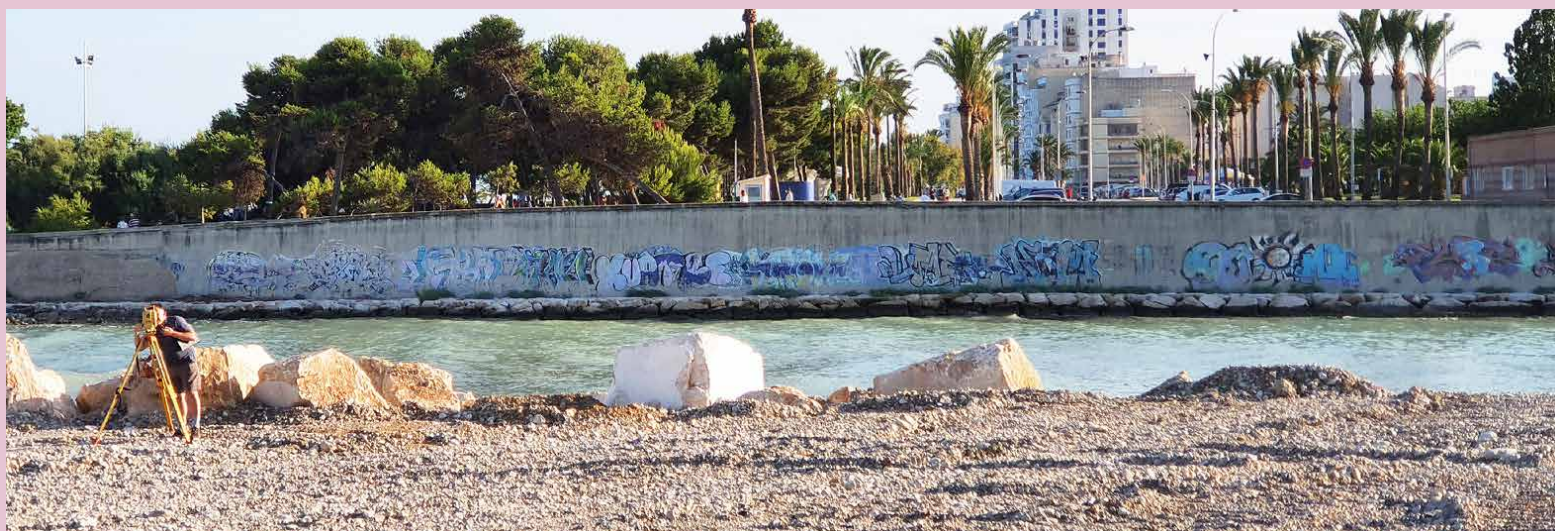
Preuen mesures per a la futura passarel·la per a vianants, sobre la desembocadura del Servol a Vinaròs, mentre l'Ajuntament prepara el plec de condicions de cara a aquest projecte que permetrà enllaçar el passeig Fora Forat amb la zona d'Els Cossis. E.F.
