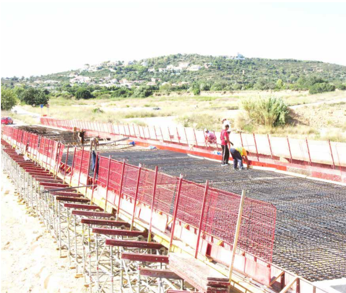
El nuevo puente ya está en fase de construcción. Foto: J.Zaragozá
