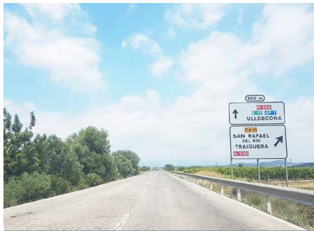
Adjudicades les obres d'accessos de la N-238
