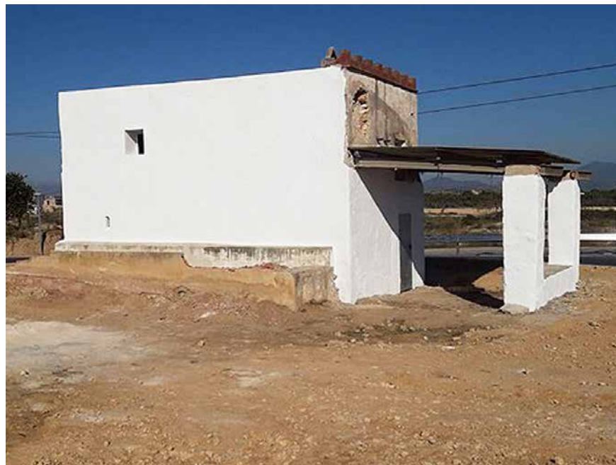
Una de les actuacions és l'adequació de la caseta típica de les zones rurals ubicada a la rotonda de Dos Vilars
