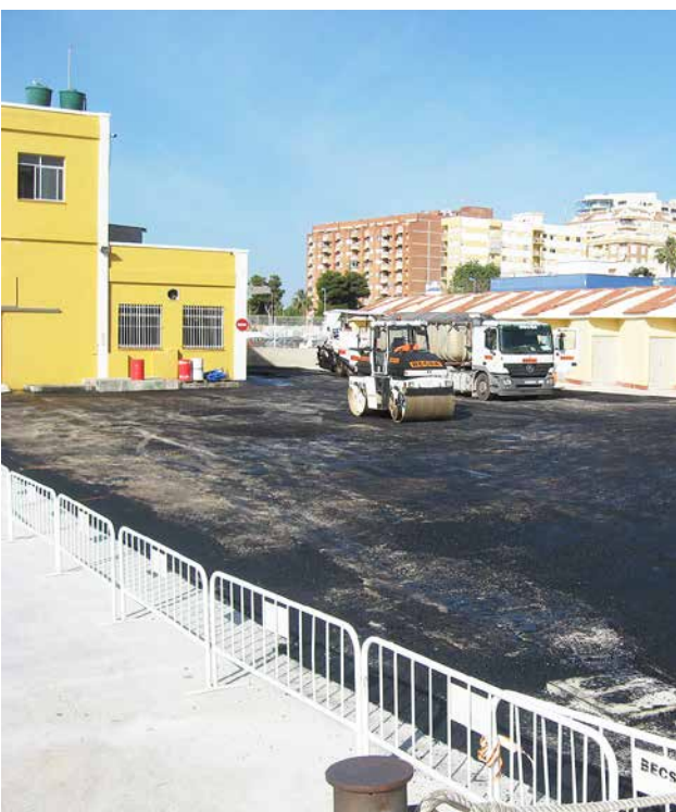
Les obres continuaven i es va asfaltar l'entorn portuari proper a la llotja
