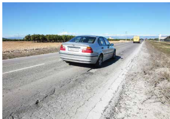
S'adjudicaven les obres de la N-238
