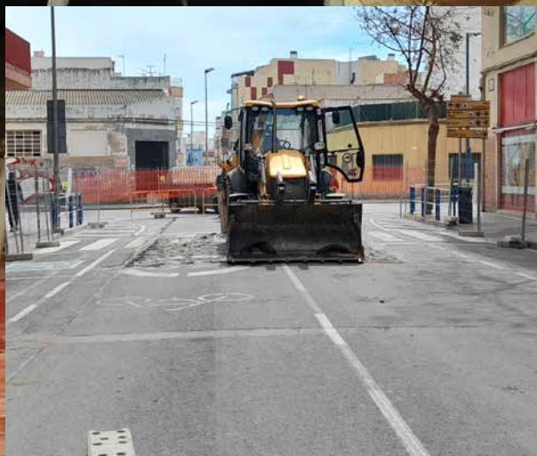
Comencen les obres de pluvials a l'avinguda de Maria Auxiliadora
