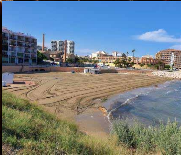
Adequació de platges per a aquest estiu
