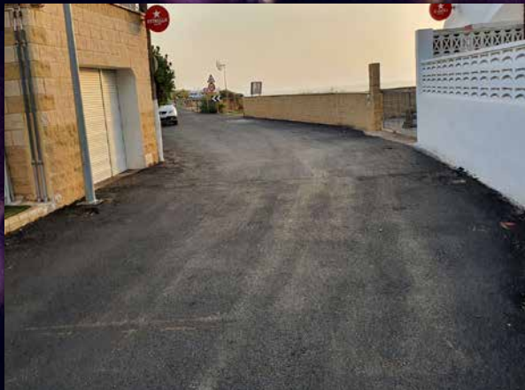
Obres d'asfaltat de diferents carrers de la ciutat
