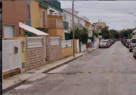
Comencen les obres del carrer Salaverria i els pluvials de l'Avda Barcelona
