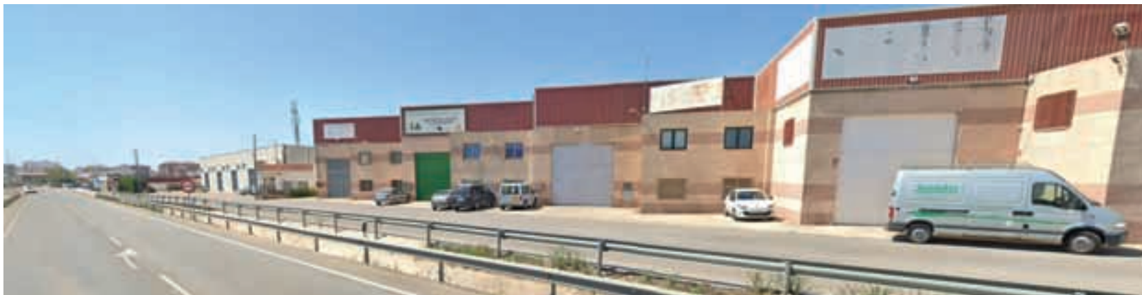
Vista de part del polígon de la carretera d'Ulldecona, que rebrà importants millores gràcies a la subvenció
