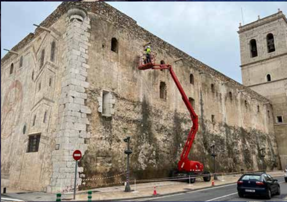
Comença la restauració de les pintures de la façana de l'Arxiprestal
