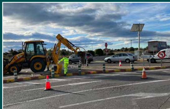
Obres de millora de l'accés al Portal del Mediterráneo
